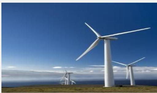
**Aerogeneradores de Eje Horizontal:** Son aquellos en los que el eje de rotación se encuentra paralelo al suelo. Esta es la tecnología que se ha impuesto, por su eficiencia y confiabilidad y la capacidad de adaptarse a diferentes potencias. Las partes principales de un aerogenerador de eje horizontal son:
